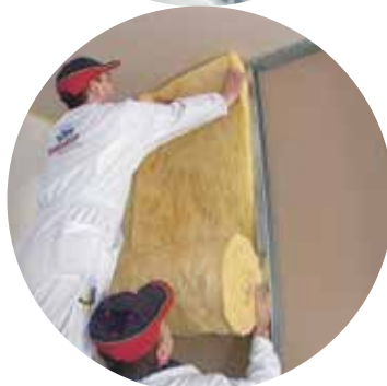
Slika 3: Izolacijo vstavimo v enem kosu
