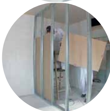
Slika 2: Namestimo prvi sloj mavčnokartonskih plošč
