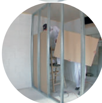
Slika 2: Namestimo prvi sloj mavčnokartonskih plošč
