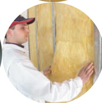
Slika 5: Pomembna je natančna vgradnja toplotne in zvočne izolacije
