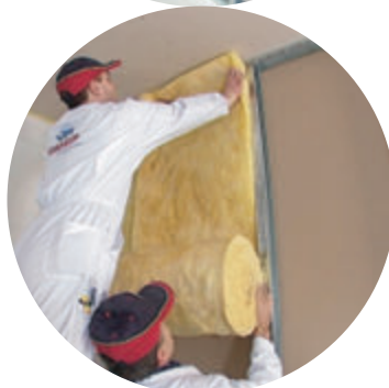
Slika 3: Izolacijo vstavimo v enem kosu
